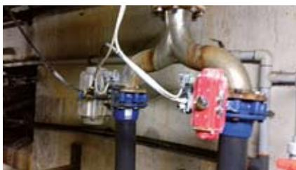
Achat de vannes automatiques complété par l'installation de variateurs de vitesse sur les pompes.
