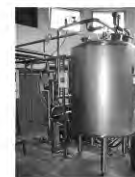
Hôpital thermal de Dax (40) Réalisation Pierre Guérin et T.T.I.A.G
