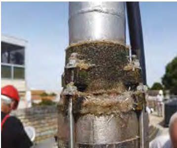
Absence de cristaux sur la pompe et sa zone d'aspiration. Présence de cristaux sur la base de la manchette
